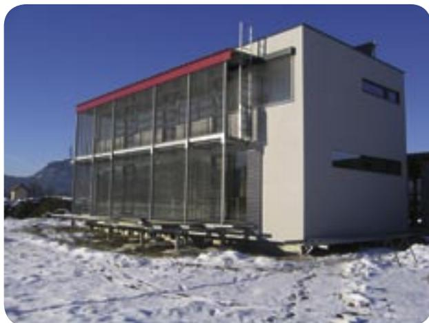
Abbildung 11: Passivhaus in Holzbauweise mit Putzfassade (Bildquelle: Weissenseer Holz-System-Bau GmbH)
