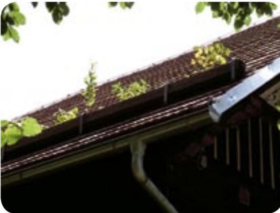
*Abbildung 19: Laub im Bereich von Schneefängern und Dachrinnen kann zu Wasser- und Eisrückstau führen (Bilquelle: Fritz Klaura)*
