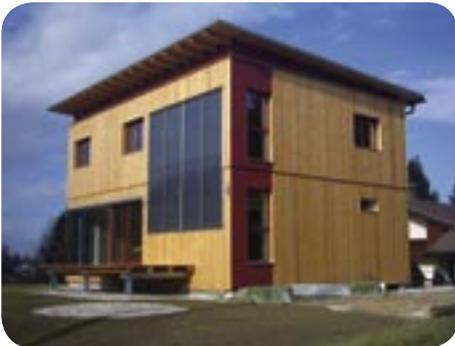
Abbildung 39: Passivhaus in Holzbauweise (Bildquelle: Weissenseer Holz-System-Bau GmbH)
